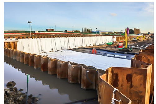
Auf einer Strecke von zwei Kilometern wurden insgesamt 97.000 m 2 Kunststoffdichtungsbahn von Solmax eingebaut.
